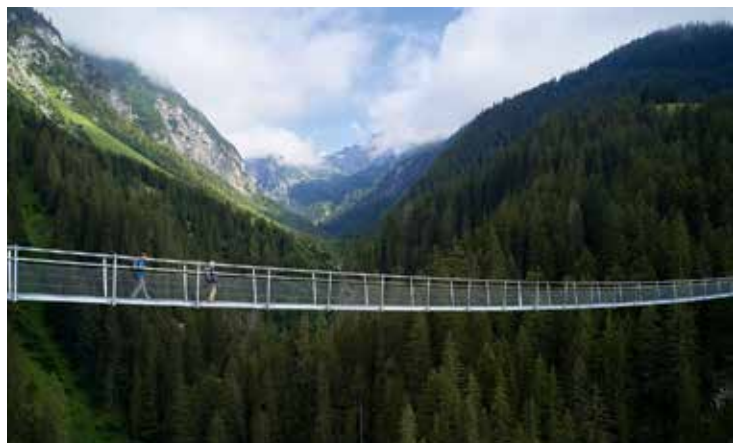
Fußgängerhängebrücke über die Höhenbachschlucht in Holzgau
