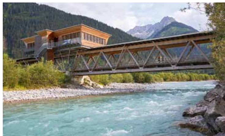
Klimmbrücke mit Naturparkhaus in Elmen
