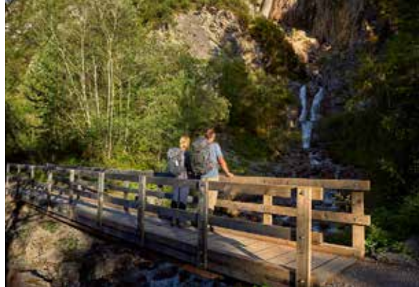
Brücke beim Wasserfall in Hagerau
