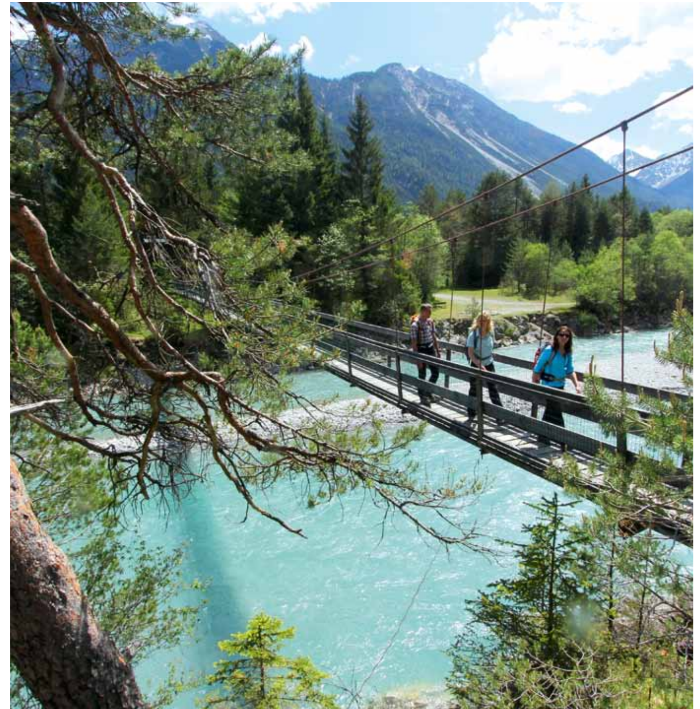
Die Forchacher Hängebrücke ist eine von vielen spektakulären Brücken auf dem Lechweg.
